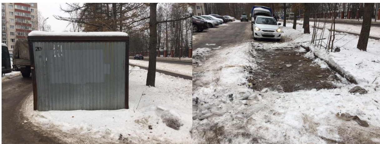
Демонтаж МТ выполнен силами ГБУ Жилищник р-на Савелки.
